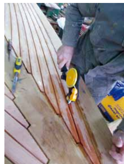
Fot. 5) Specjalna taśma na dno rowka zapobiegająca rozrywaniu fugi
