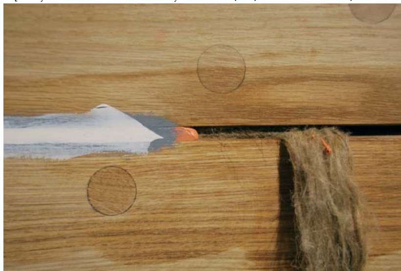
Fot. 5) Uszczelnianie planek [www.complexyacht.pl]
